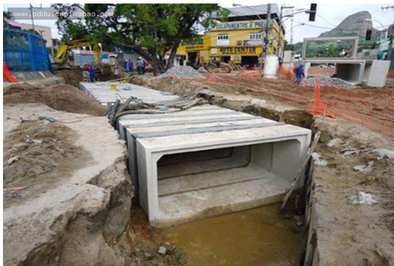
Figura 3 – instalações do sistema de macrodrenagem urbana em obra.
